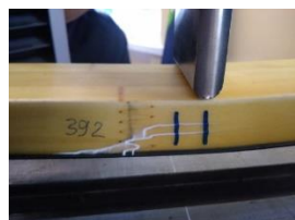
Разрыв в зоне шипового соединения и расслоение древесины
